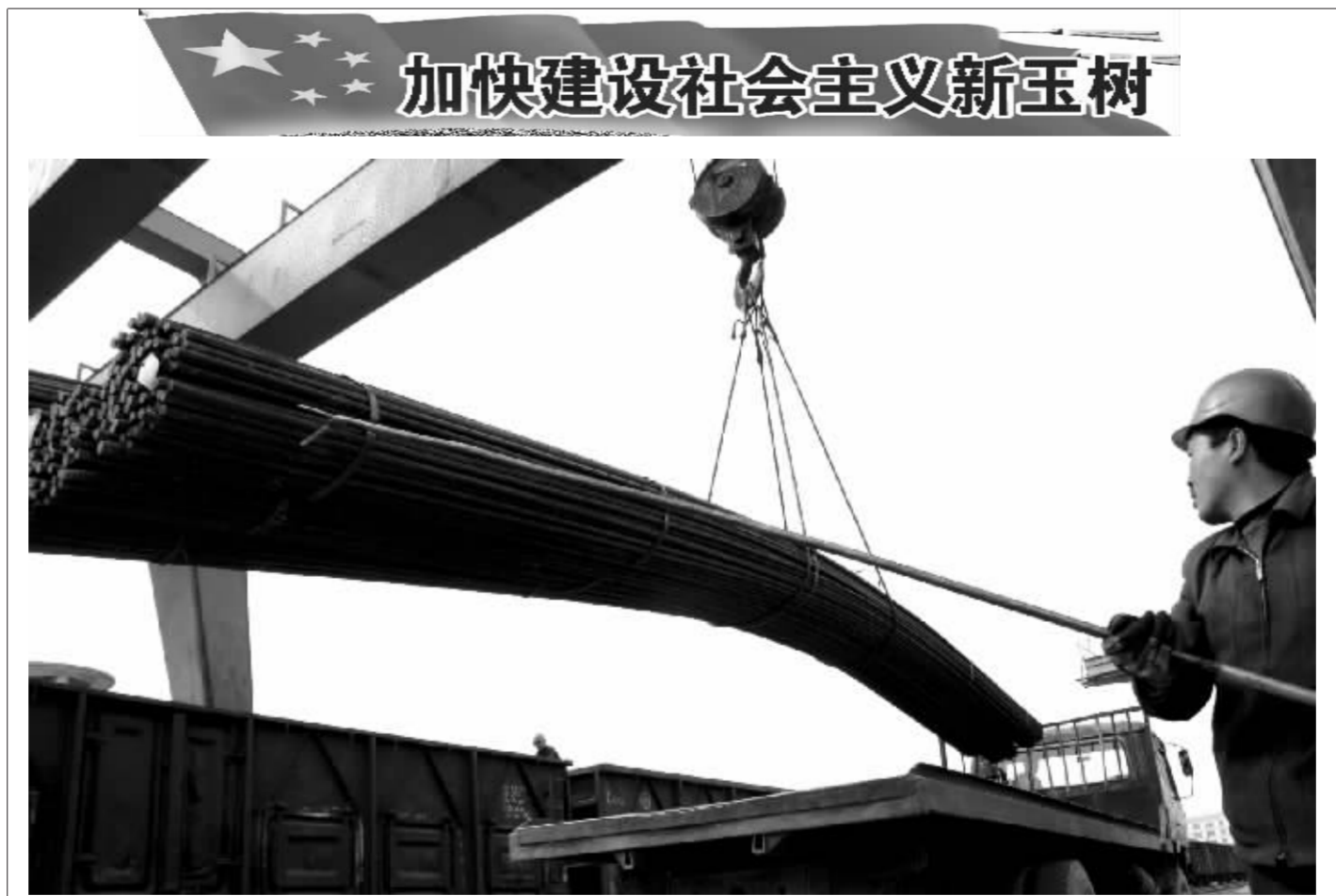
3月31日,在青藏铁路公司西宁北站货站站内一片忙碌。据了解,这个站是去年为玉树抗震救灾、重建只用2个月建成的。从去年6月30日投入使用以来,全站职工为确保物资及时、畅通运往灾区,克服困难圆满完成了来自全国的各种物资运输任务。截止到3月31日,共接收抗震救灾、重建物资1823车,112835吨。其中:水泥356车,21681吨;钢材72车,43984吨;木材321车,18736吨;工业用盐372车,25878吨;还有粮食、食品、棉被、棉衣、帐篷等物资近3000吨。本报记者/晓刚 摄
